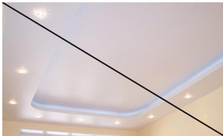
Плохо Многоуровневые гипсокартонные конструкции
